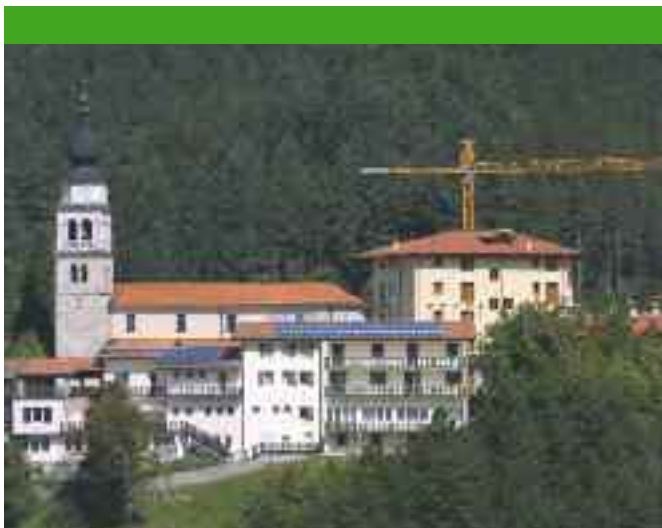
L'impianto fotovoltaico sul tetto della sede del Parco (Foto: Archivio PNPG - Marco Di Lenardo)
