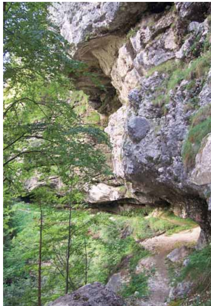
Parete aggettante in prossimità delle sorgenti
